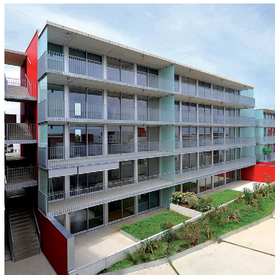
Architecte : Puig Pujol - Photographe : B. Hanne
